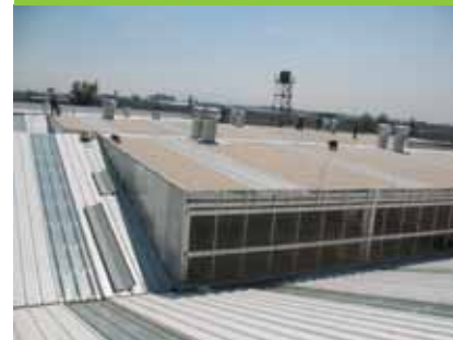
Centro Distribución Anwo Constructora Chiavari
