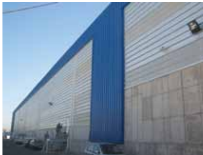
Proyecto Forus Constructora Tecsa
