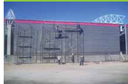
Embolletadora Coca Cola (con-con) Constructora Izquierdo Ltda.
